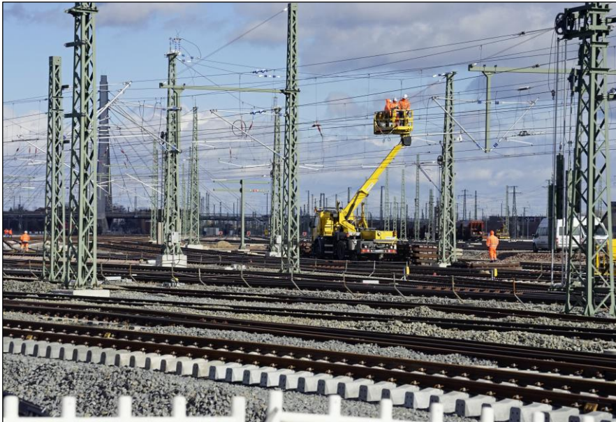
Das Eisenbahnnetz in Deutschland sollte nach Schweizer Vorbild vollständig elektrifiziert werden; im Bild Fahrleitungsarbeiten im Hauptbahnhof von Halle an der Saale; Foto: DB AG / Volker Emerleben.
